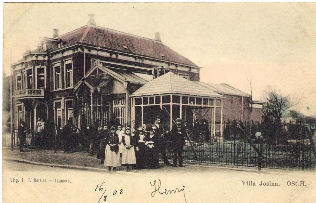
De villa op een ansicht, die in 1903 is verzonden.
